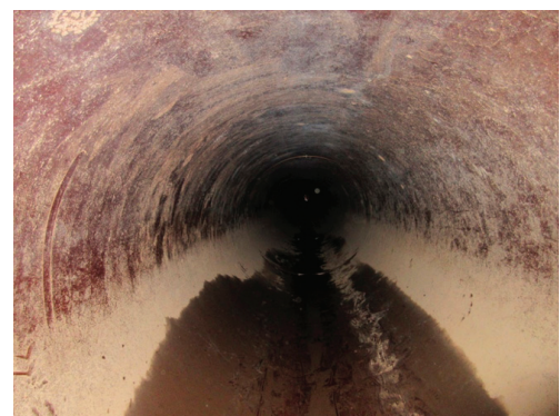
図6 測定した実際の農業用水管 (上：地上の写真，中：アクセス用マンホール， 下：管内の写真（内径1,350mm，定尺4,000mm））
