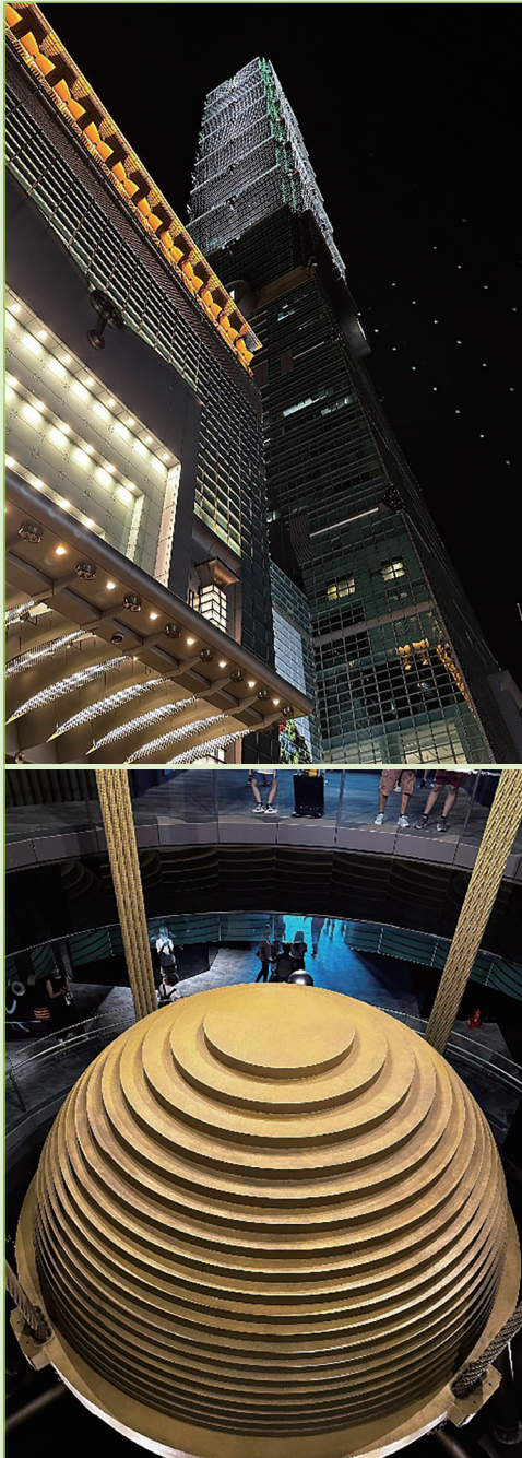
図2 台北 101 とチューンドマスダンパー
