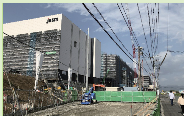
図 2 建設中の JASM の第 1 工場 (2023 年 4 月撮影)
