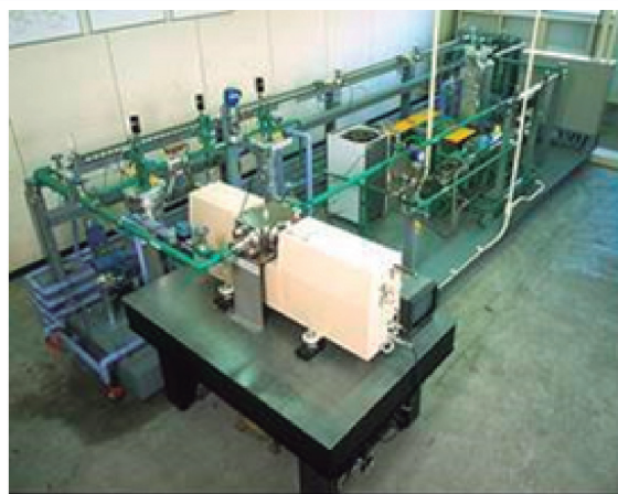
図7 CO 2 ヒートポンプ基礎実験ループ (熱出力 6 kW, 1996 年設置)
