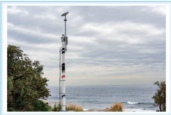
図 3 熱海市初島の Starlink を用いた au 基地局
