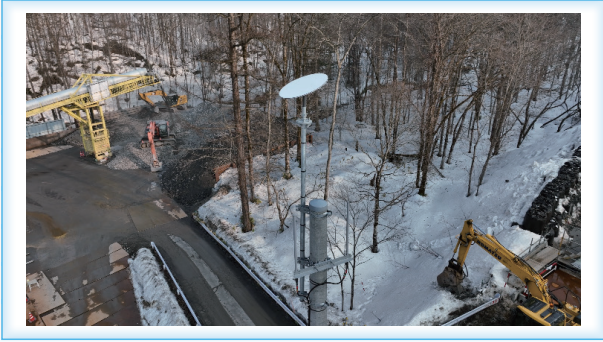
図 10 北海道新幹線渡島トンネル（上二股）工区（JRTT 発注）工事現場の SML 利用
