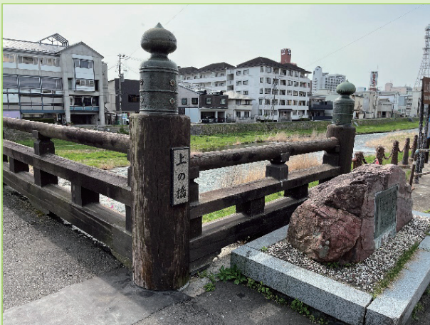
図4 中津川に架かる上の橋の擬宝珠
