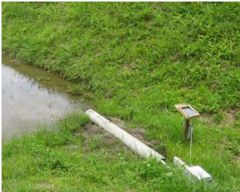
図 2 設置現場の様子
