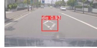
図7 欠損を伴う路面標示
