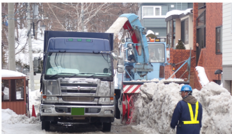
図1 排雪作業(路肩の雪をダンプトラックへ積込)
