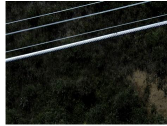
図 4 異常を含む架空地線の画像
