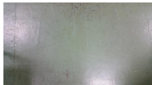
図 4(a) 路面画像の例
