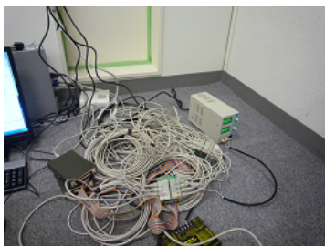
図1 配線状況 (床下に配置)
