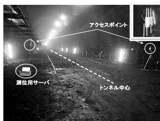
図 4: トンネル施工現場の実験状況
