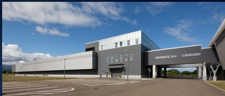
さくらインターネット石狩データセンタ PUE=1.116 (PUE=データセンター全体の消費電力÷IT機器による消費電力)
