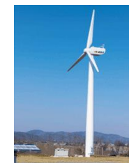
風力発電設備
