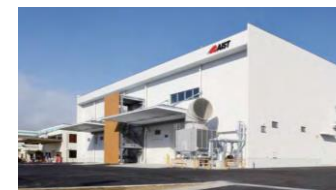
スマートシステム研究棟
