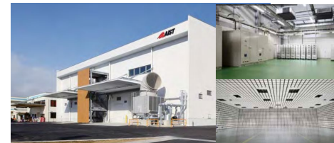
スマートシステム研究棟
