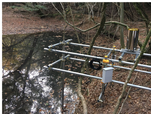
図 12 設置した水位センサと降雨量センサ
