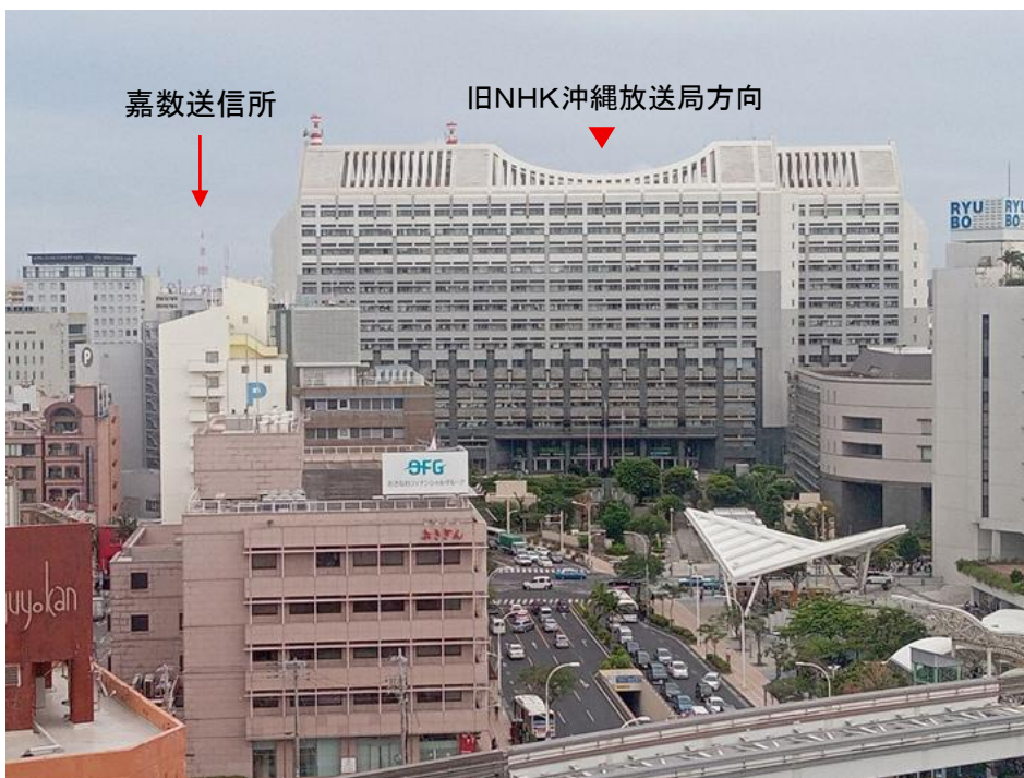
RBC 琉球放送本社の屋上から見た沖縄県庁舎
