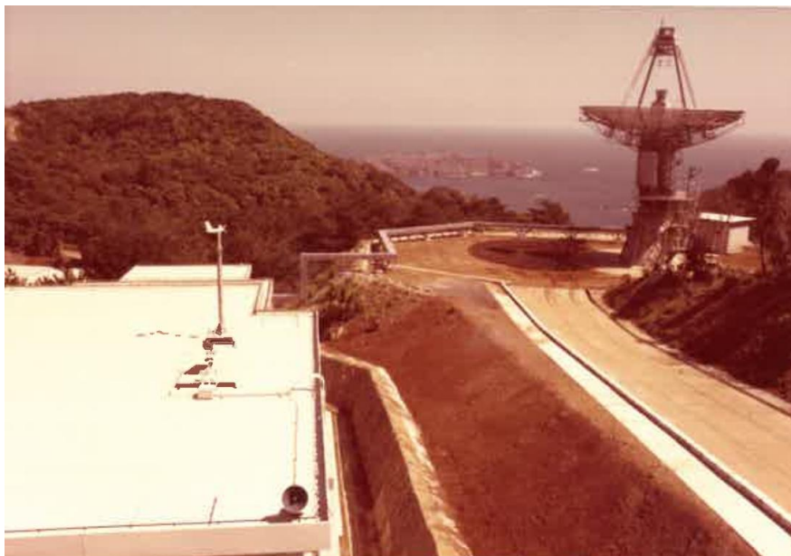
写真 1 開発設置当初のアンテナ
