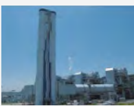
火力発電プラント工事
