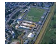
水環境プラント工事
