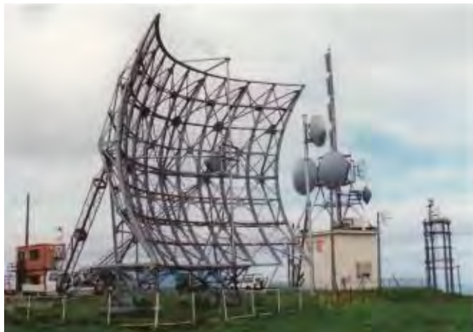
大沼テレビ中継局の大口徑パラボラ(10mx8m) NHK-G, E, HBC, STVの4波共用受信アンテナ
