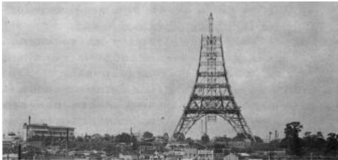
本体部の完成, 1958年(昭和33年)8月
