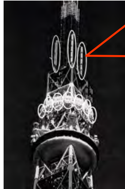
上側：5段双ループアンテナ，4面 下側：2段双ループアンテナ，15面 MX 14ch, UD 16ch, UHF
