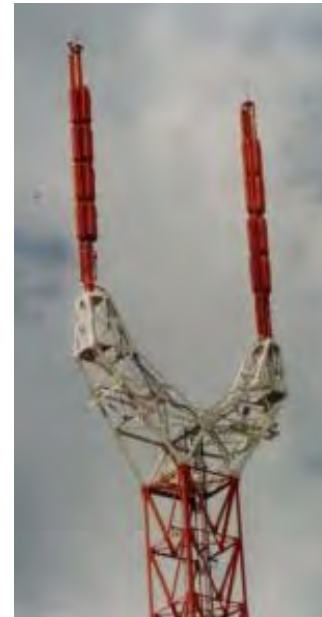
キャンデラブラアンテナ(銚子テレビ中継局)(4L6段1面・4L4段3面x2)
