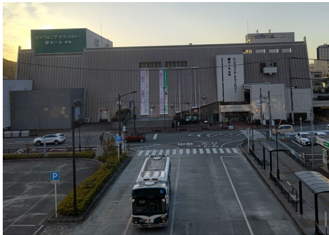
写真1 シンフォニアテクノロジー響ホール伊勢
