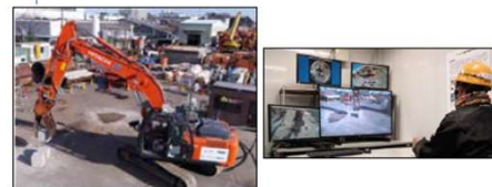
建機の遠隔監視・制御
