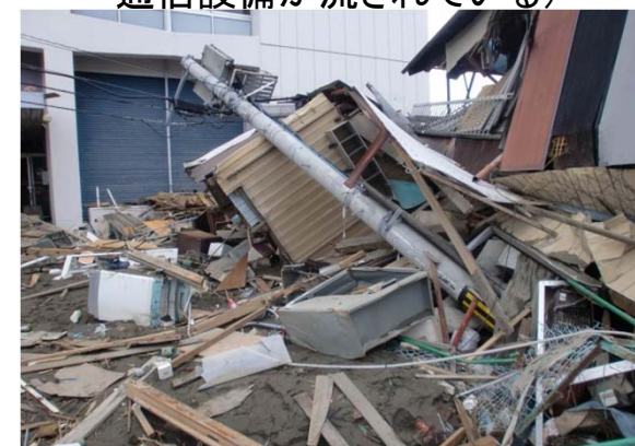
写真: 倒壊した電柱(石巻市)
