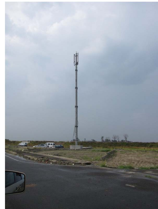
写真: 被災した携帯電話基地局(仙台市) (鉄塔は残ったものの足元では断線し 通信設備が流されている)
